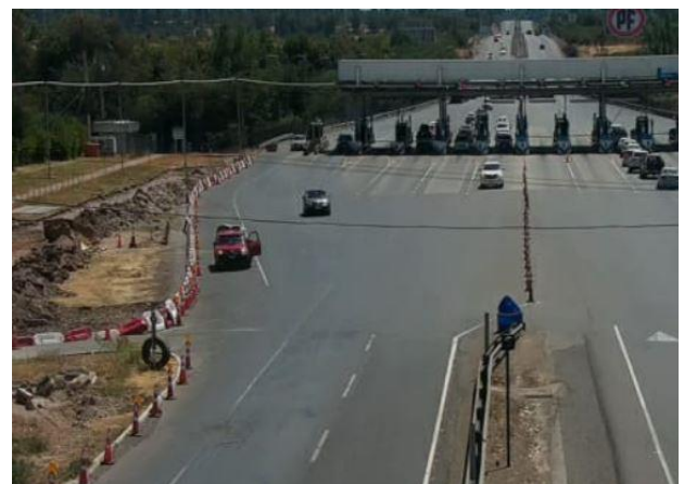
Inicio trabajos ampliación lado poniente PP Río Claro (km 220,330)
