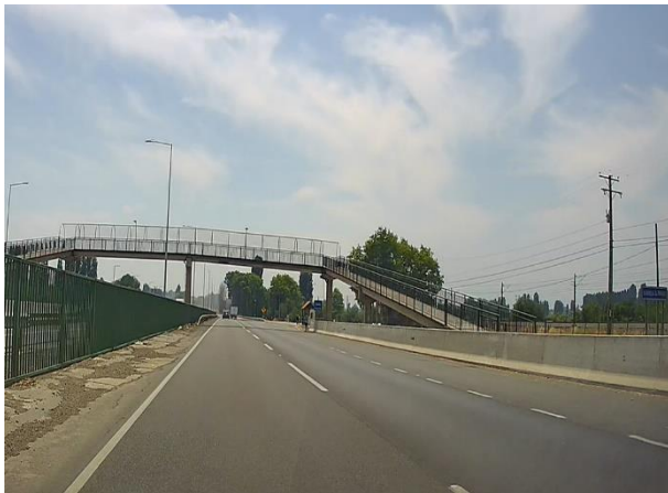
Pasarela Peatonal El Peñasco (Km 321,212)
