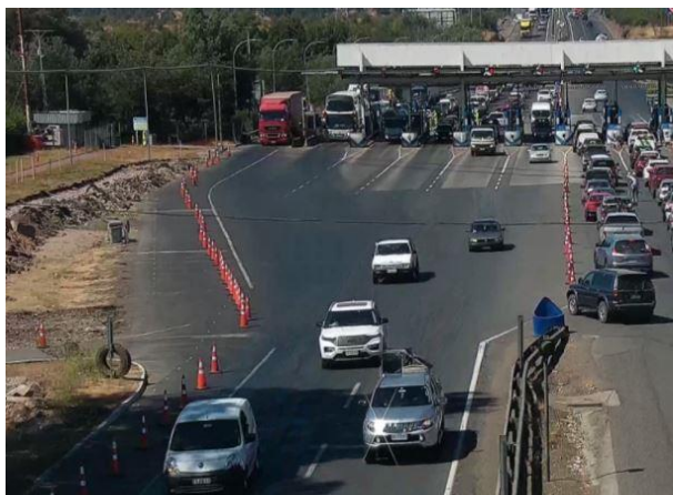
Inicio trabajos ampliación lado poniente PP Río Claro (Km 220,330)
