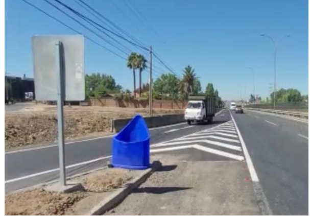
Trabajos Salida 8 Sur (Km 254,340), finalizados el 13.12.2021
